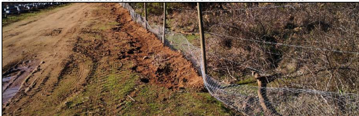
Foto 3. Malla protectora de conejos instalada durante el transcurso del tratamiento.
